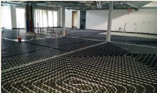
Une crèche de Tournai a été équipée de 700m<sup>2</sup> de Spider, le système chauffage sol Giacomini ultrafin, ultraperformant et de faible inertie.
